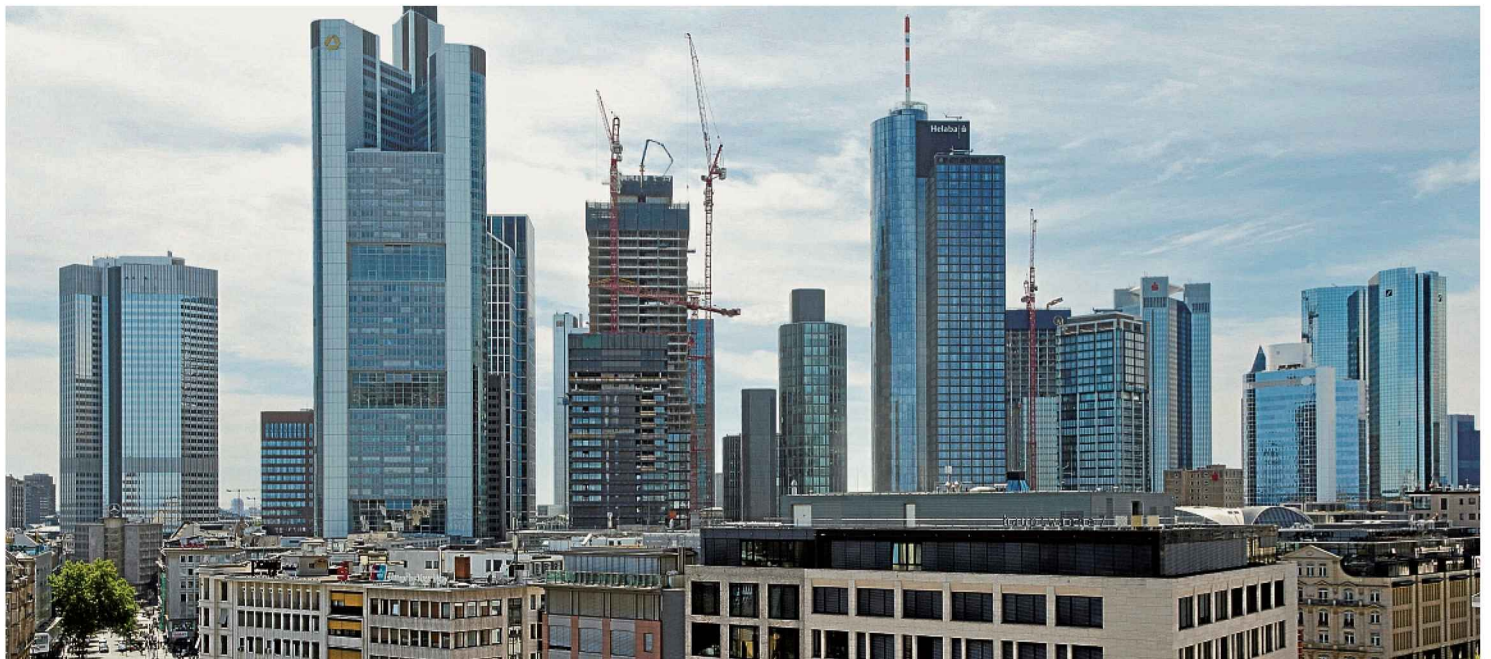
Überall in der Frankfurter City wird gebaut. Ein Großteil der entstehenden Büros ist bereits vermietet.
